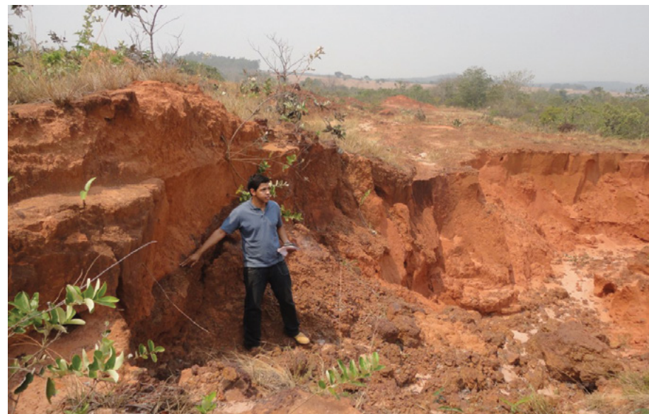
Figura 11 – Erosão em cabeceira de drenagem sobre Plintossolo Pétrico (inferior) e Latossolo (superior), Tangará da Serra, MT. Fonte: acervo dos autores, 2022.
