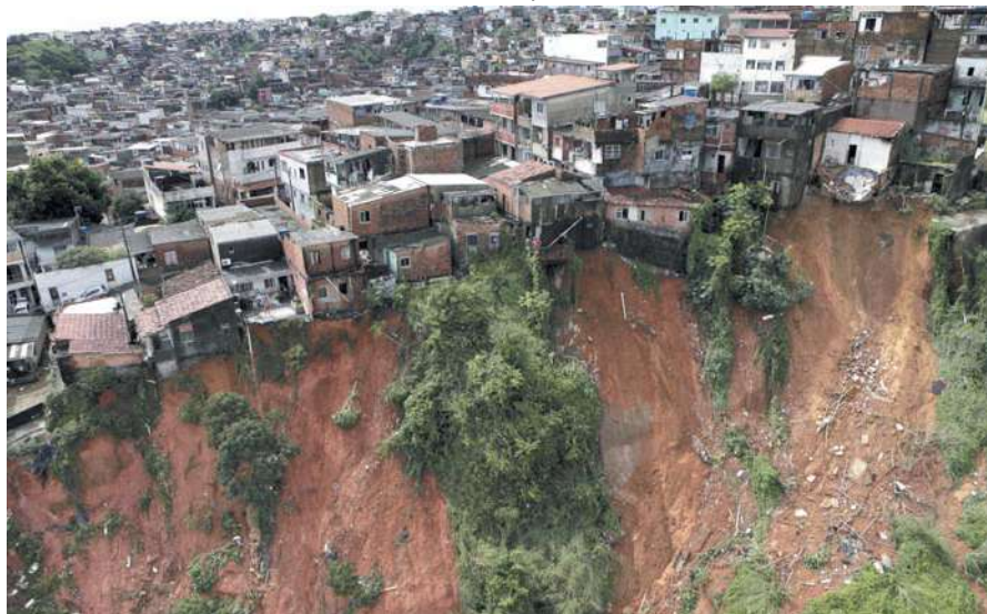
Deslizamentos provocados por fortes chuvas em Salvador (BA)
